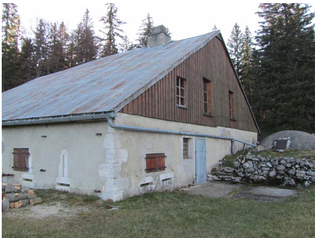
Façade nord, même réflexion que ci-dessus pour la fenêtre.
