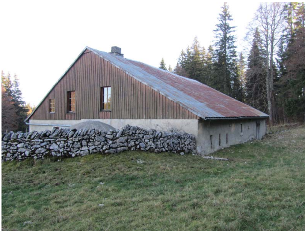
Façade nord et arrière du chalet
