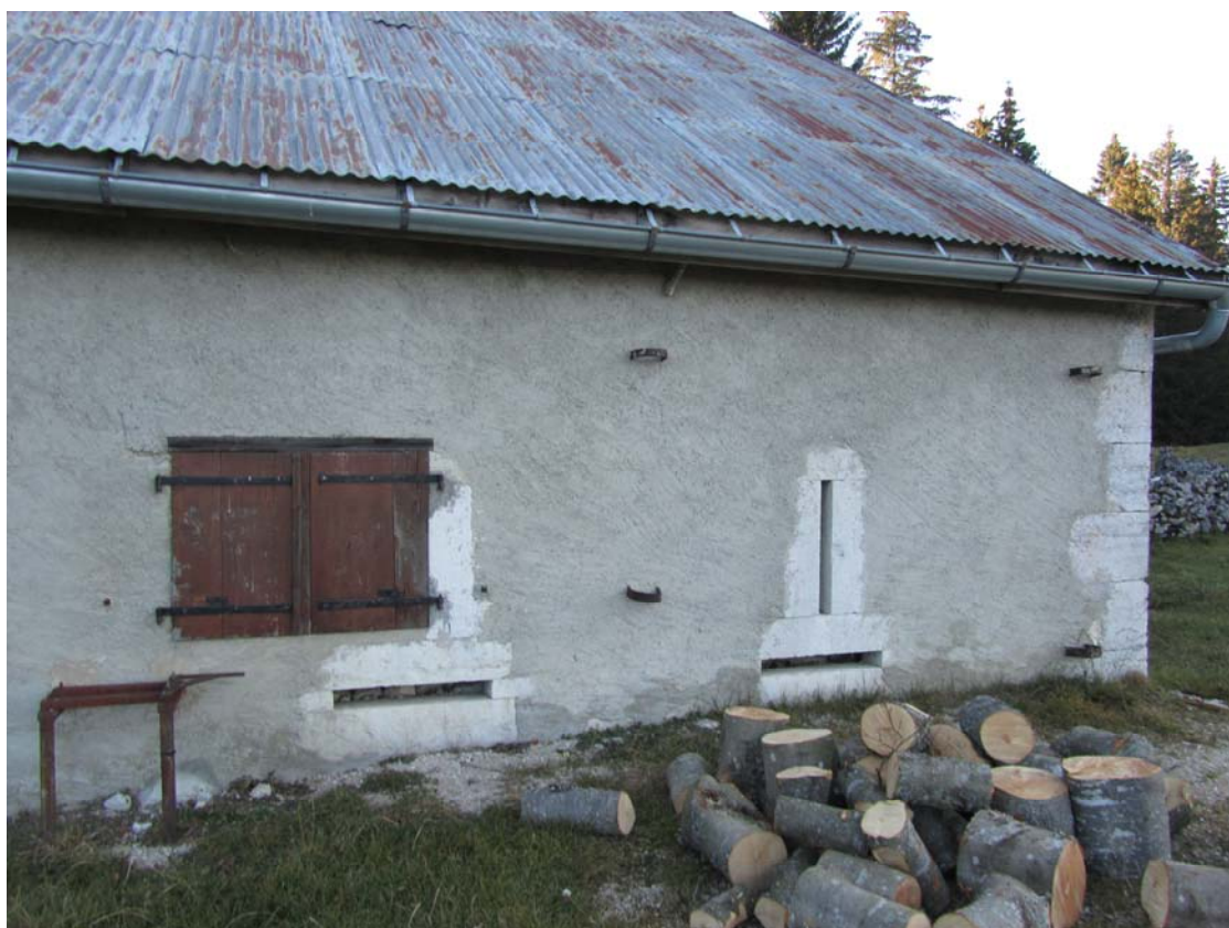
Angle nord, ancienne chambre à lait. La fenêtre, avec son volet, à été créée ultérieurement.
